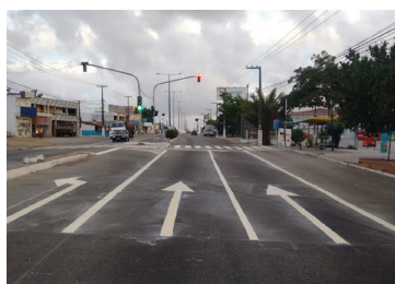
Detran realizou sinalização semafórica
